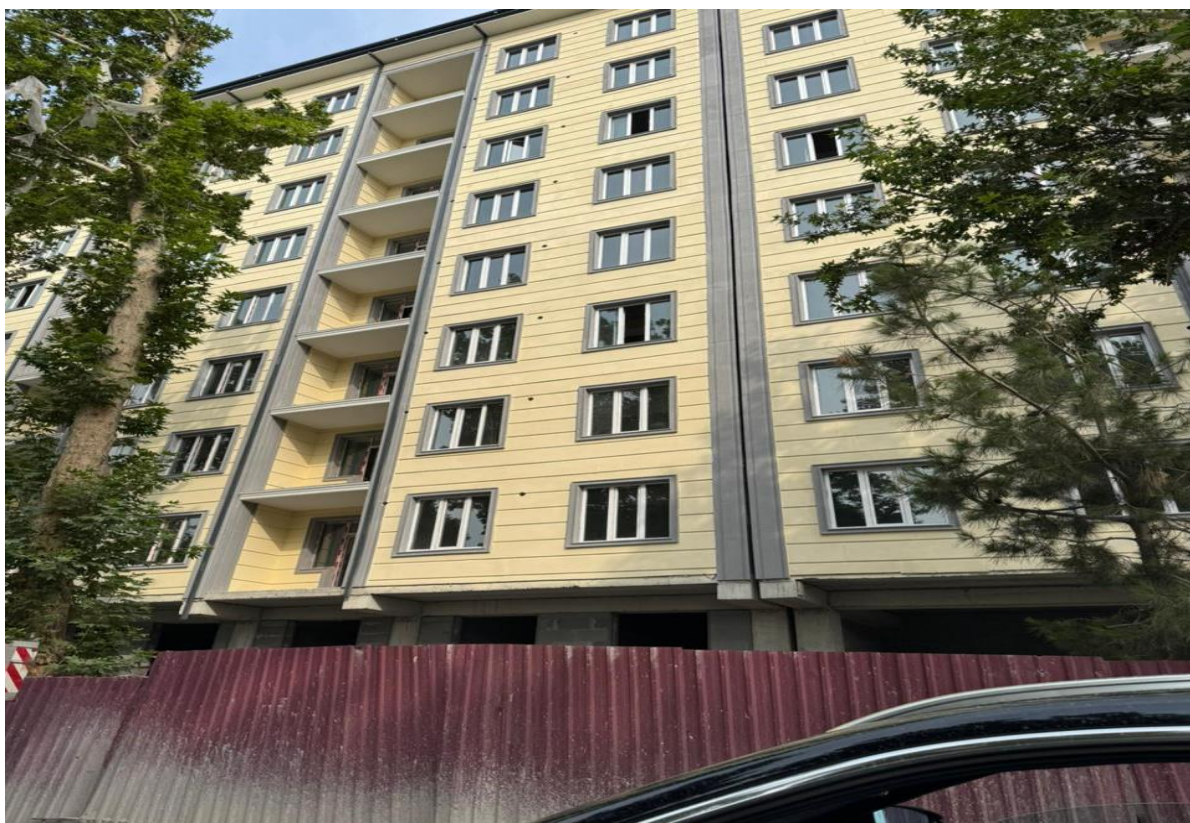
Строительство многоквартирного дома для сотрудников
