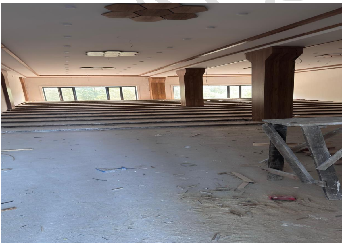
Этап строительства дополнительного учебного корпуса.
